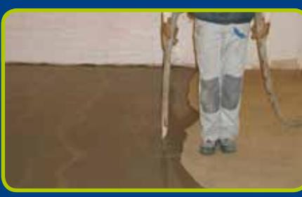
Ungestreckte NIBOPLAN BEST kann mit BOSTIK PUMPING TRUCK gepumpt werden.
